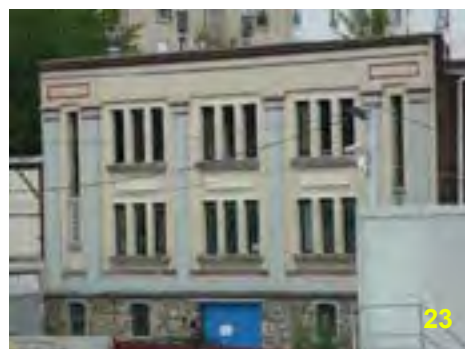
Baies tripartites allongées en hauteur pour l'usine Majola située au 4 rue Nay
