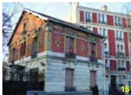
22 rue de la légion d'Honneur Refends monochromes à rez-de-chaussée et briques polychromes au premier étage
