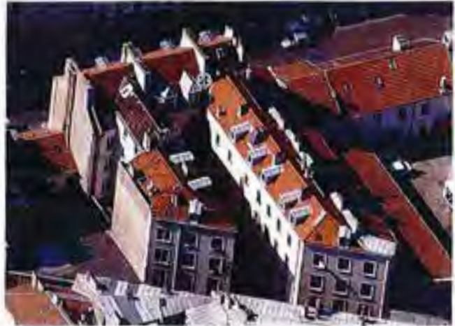
Vue aérienne oblique qui montre la quasi symétrie des deux ailes secondaires et l'utilité, pour l'éclairage de l'aile principale, du décroché du corps Est de l'aile Sud (flèche). (A. - 2014/04/2015 © Institut 2014)
