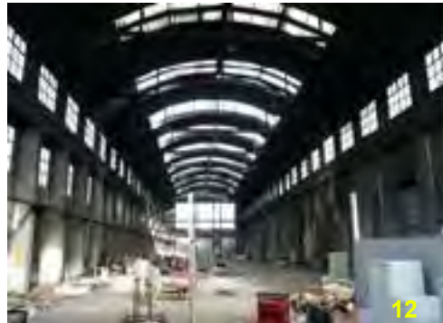
Entrepôt de la SNCF Charpente béton
