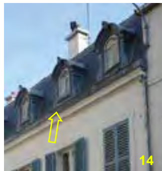
Chéneau posé sur corniche
