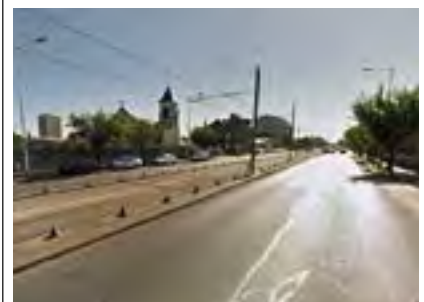
Vue de l'église Saint-Lucien dans son contexte spatial, frappée de la présence de la route Nationale 186 qui s'inscrit comme une source de rupture, bien que les vues soient directes et ne forment pas obstacles.
