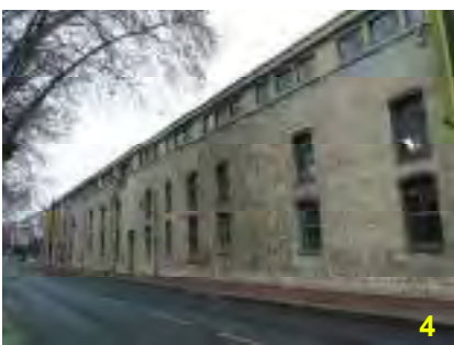
Anciens magasins des EMGP Petits moellons de pierre
