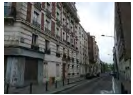
Détail de la façade rue Nicolas Leblanc où l'on voit la différence, au RDC, entre les travées ayant conservé leur décor et celles « lissées » à droite de la devanture.
