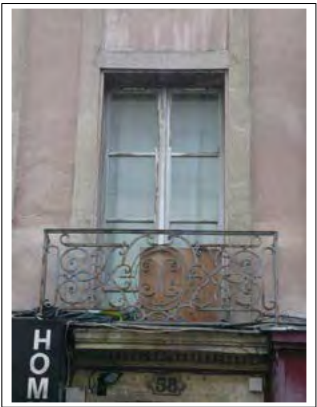
Détail du garde-corps ancien au-dessus de la porte d'entrée du 58 rue Gabriel Péri. Département de la Seine-Saint-Denis, DCPSL, SPC
