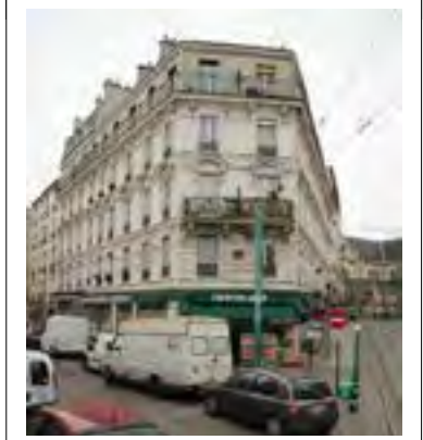
ci-dessus : 2 rue Dezobry-8 rue Auguste Delaune © Jacques MANGIN – UASD – Département de la Seine-Saint-Denis
