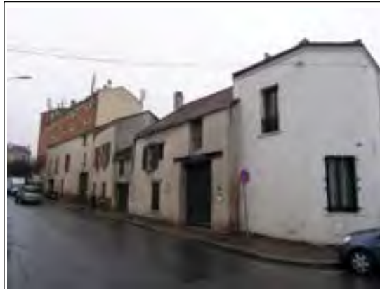
1 - Front partiel des numéros 6 à 12 rue Jollois. Les anciens portails cochers avec grand linteau bois et les allèges basses des baies du RDC témoignent de la typologie rurale
