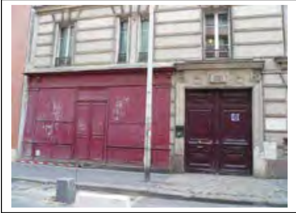
Qualité du pied d'immeuble Département de la Seine-Saint-Denis, DCPSL, SPC
