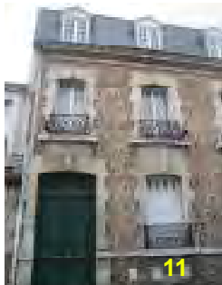
23bis rue Pinel Façade en meulière
