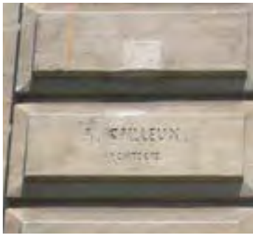
« Signature » de l'architecte en façade à préserver
