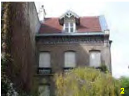
Emploi de la pierre de taille très rare pour le logement individuel, ici au 6 rue Denfert-Rochereau
