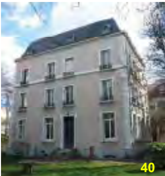
Construit en 190, le logement du directeur des EMGP
