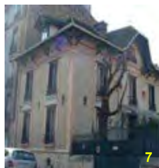
Toit complexe en tuiles plates au 7 rue des moulins gémeaux
