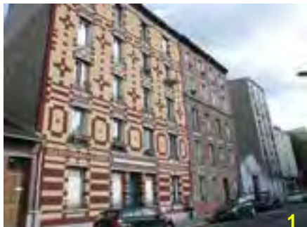
Au 8-10 rue Bonnevide, logement à rez-de-chaussée. Le rez-de-chaussée a conservé ses dispositions d'origine.
