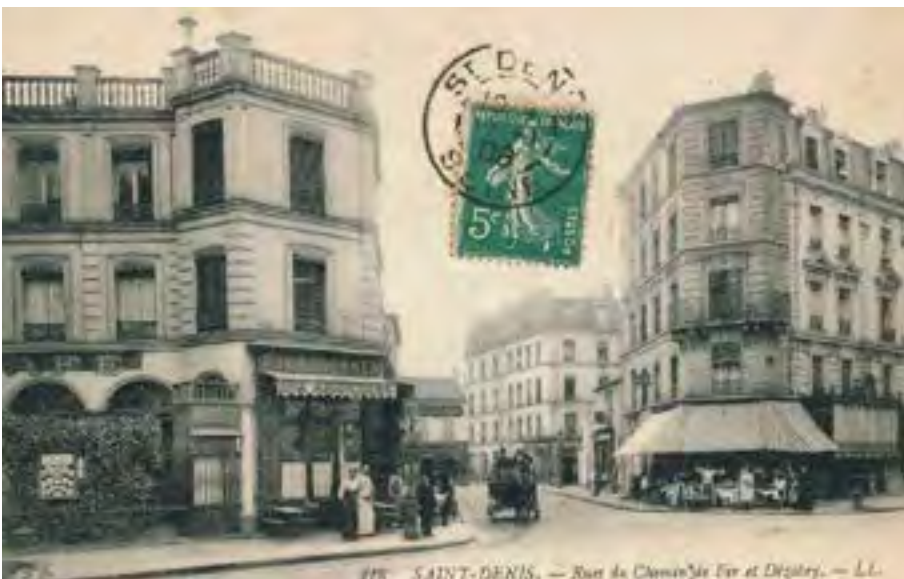
ci-dessus à gauche : le 27 rue Auguste Delaune, ancien café et salle de bal. A l'angle, ce bâtiment est du même gabarit que le 3 rue Dezobry. Ci-dessus à droite : le 1 rue Dezobry avant la disparition de sa modénature et de son décor : les façades formant un tout cohérent avec le reste des bâtiments du carrefour.
