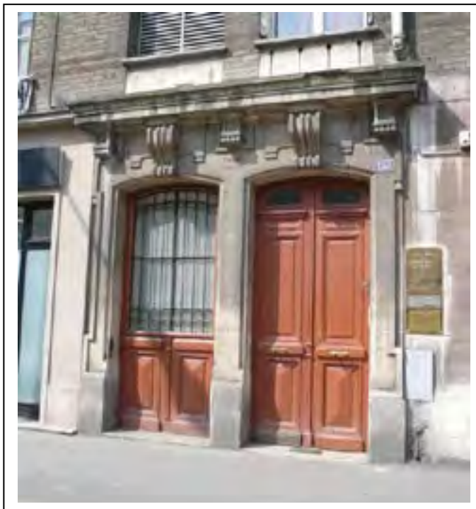
Porte d'entrée et ouverture de loge au 135 rue Gabriel Péri. Département de la Seine-Saint-Denis, DCPSL, SPC
