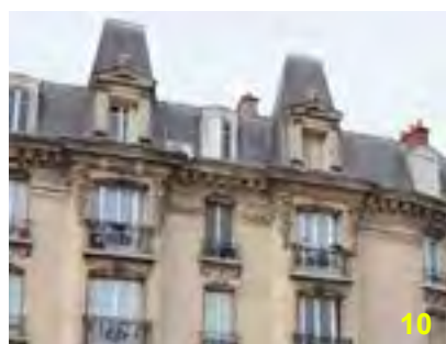
Sur la place de la Résistance, toit dit à la Mansart magnifié par des toits en pavillons dans l'axe des travées principales dotées d'oriels
