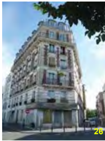
Au 19 rue Denfert-Rochereau, immeuble de style Louis XIII : traitement de l'angle avec façade à deux travées couplées par un balcon au 2 ème étage et balcon filant au 5 ème étage.
