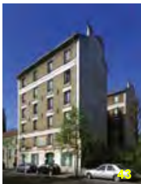
1897-1899 – logement social « le Foyer » – G. Guyon (architecte) 137 bis rue Gabriel péri
