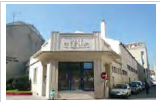
Salle paroissiale, 8 rue de la Boulangerie Département de la Seine-Saint-Denis, DCPSL, SPC
