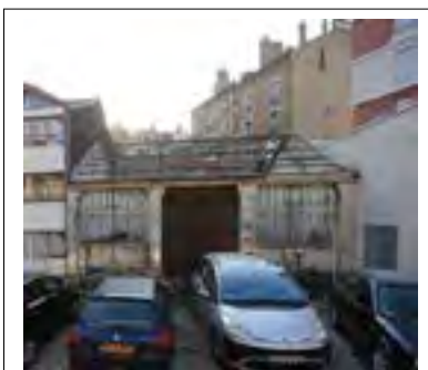
Vue de la chaufferie C depuis la cour. © Jacques MANGIN – UASD - Département de la Seine-Saint-Denis.
