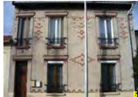
17 rue Louis Larivière Façade en brique
