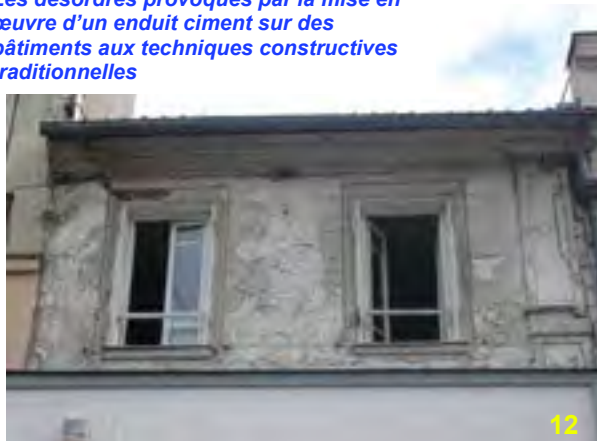
10 – Décollement formant poches et fissures
