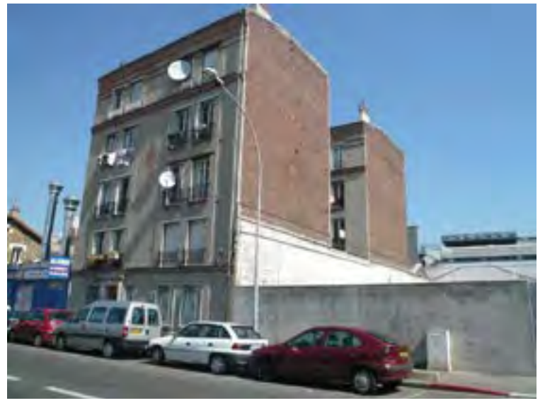
Murs pignons est des immeubles Département de la Seine-Saint-Denis, DCPSL, SPC
