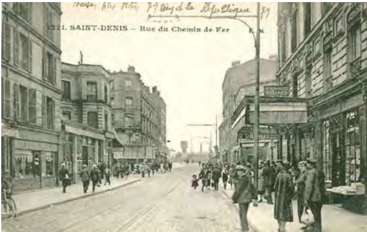
En haut : cette vue est prise en contrebas depuis l'ouest du carrefour entre les rues Dezobry et Auguste Delaune, au fond le chevet de Saint-Denis de l'Estrée. En bas : à l'inverse vue depuis la rue Auguste Delaune, à l'est du croisement avec la rue Dezobry, en fond la place de la gare.
