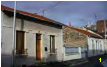
21 – 25 rue d'Arnouville Mur gouttereau sur rue
