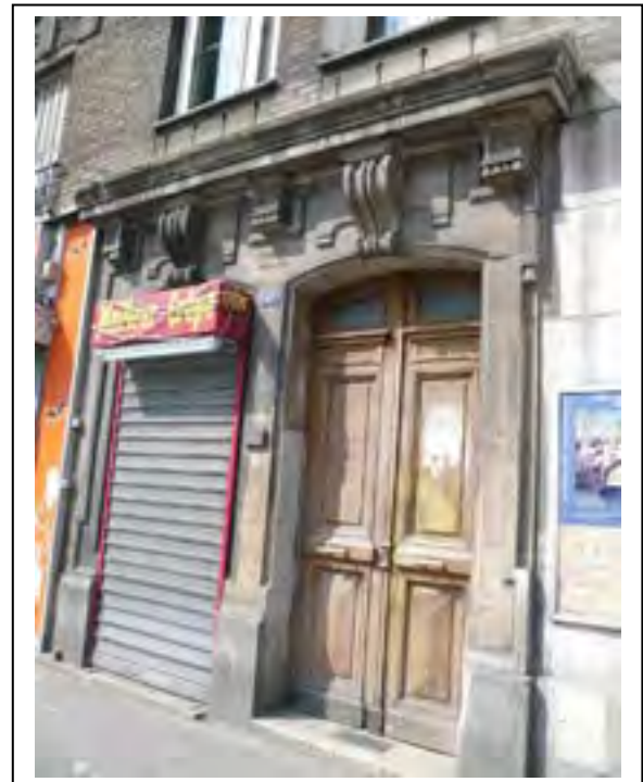
Porte d'entrée et ancienne ouverture de loge de gardien condamnée au 135 bis. Département de la Seine-Saint-Denis, DCPSL, SPC
