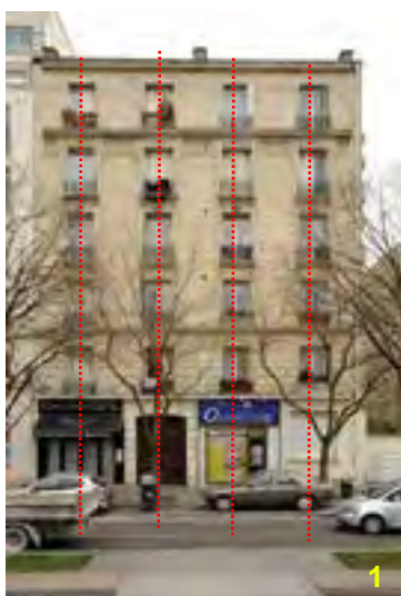
Symétrie parfaite à l'exception du rez-de-chaussée dont la porte est désaxée et composition régulière avec travées de largeur égale
