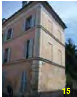
15 Au 10 rue Emile Conroy l'angle du bâtiment est traité par un pan coupé formant, à rez-de-chaussée, chaîne harpée en pierre de taille.
