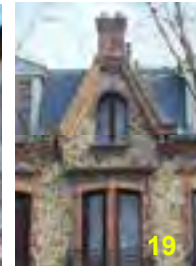
Élément central du pignon pour cette cheminée du boulevard Carnot
