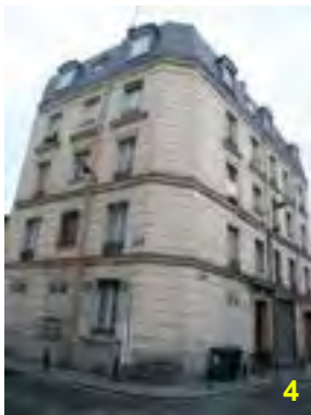
Enduit plâtre et/ou chaux au 6 rue de la Boulangerie
