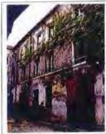
Bâtiment C © Michaël Wyss - UASO
