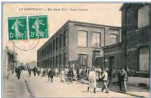
Vue du site de Johnson lorsque les volumes bâtis en brique avec les grandes baies à arc segmentaire vont servir à la reprise du site par Champagnole. L'architecture et les infrastructures sont remployées.
