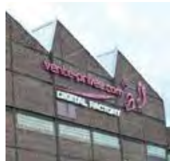
Sur les façades non pourvues d'espace publicitaire, l'intégration d'une signalétique légère, lettre à lettre, est intéressante car elle évite la pose d'un encart qui cache alors totalement l'architecture et les lignes structurelles du bâtiment.
