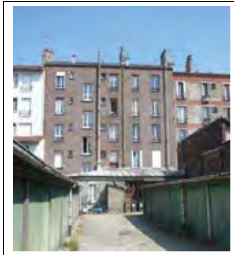
ci-contre : façade secondaire du 17 rue Dezobry Département de la Seine-Saint-Denis, DCPSL, SPC
