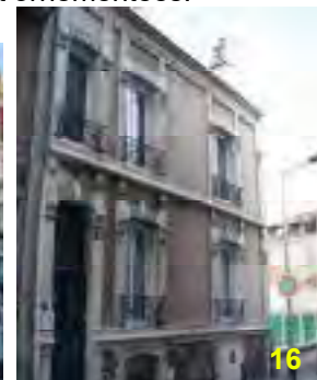
5 impasse Thiers Détails soignés au niveau du soubassement ainsi que des encadrements de baies.
