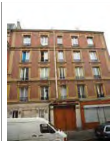
21 rue Dezobry © Jacques MANGIN - UASD - Département de la Seine-Saint-Denis
