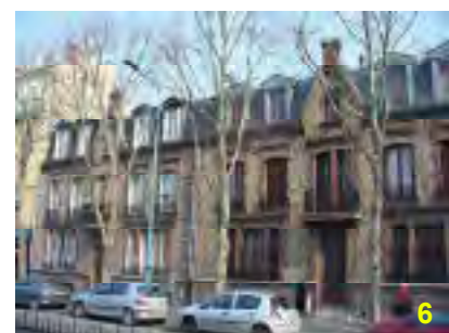
28 – 30 boulevard Carnot , de facture plus bourgeoise, ces maisons sont symétriques à quelques détails près.
