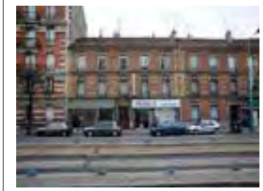
4 et 6 boulevard Carnot Département de la Seine-Saint-Denis, DCPSL, SPL © Jacques MANGIN - UASD - Département de la Seine-Saint-Denis
