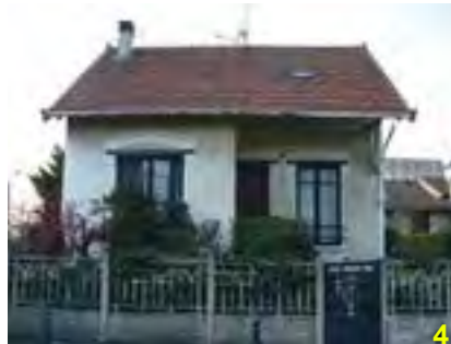
1 rue Voltaire Façade enduite
