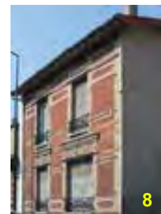
17, rue Dalmas Briques polychromes, céramiques et garde-corps ouvragés.
