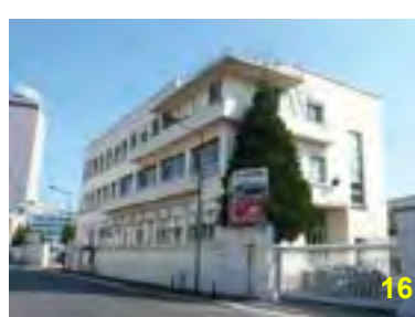
CAMS, Usine de fabrication d'hydravion au 25 rue Pleyel
