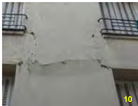
7 – Faïçnage de l'enduit pulvérulent et efflorescence
