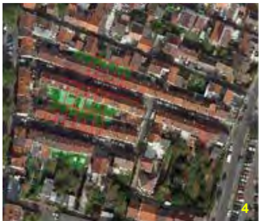
Ensemble rue Collerais, rue Loubet et avenue Roger Sémat
