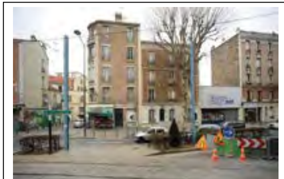
13 boulevard Félix Faure, immeuble au centre, et, à droite, le mur pignon en meulière du 19 boulevard Félix Faure (3 passage Lacroix) © Jacques MANGIN – UASD – Département de la Seine-Saint-Denis
