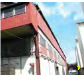
Usine de lessive Phenix Eclairage latéral par de grandes baies filantes au niveau des murs gouttereaux ou des murs pignon.
