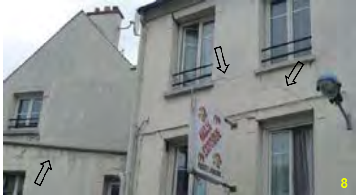
7 – Faïçnage de l'enduit pulvérulent et efflorescence
