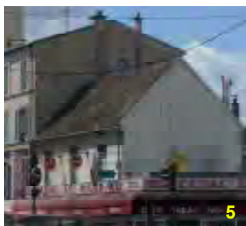
Toit à deux pentes à 45° couvert en tuiles plates au 149 rue Gabriel Péri
