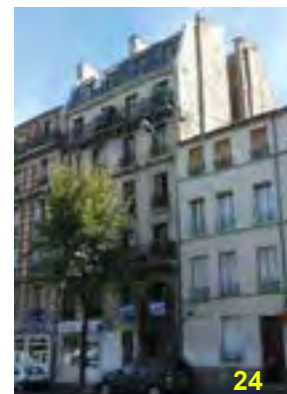
Vers 1860 – 1870 32 boulevard Marcel Sembat © Jacques MANGIN – UASD – Département de la Seine-Saint-Denis
