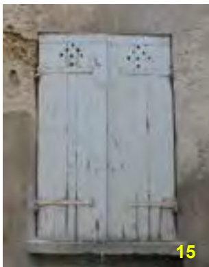
Volets pleins en bois avec trous d'aération en partie haute
