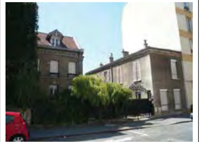
Ci-dessus : à droite, maison b Département de la Seine-Saint-Denis, DCPSL, SPC
