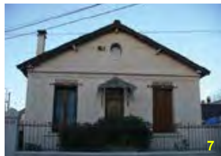
13 ter rue Berthelot La façade est animée par un jeu de juxtaposition de plusieurs matériaux: brique, enduit et carreaux de faïence.
