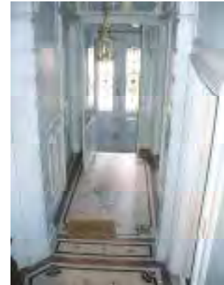
Certains décors ne permettent pas d'envisager une isolation par l'intérieur.
