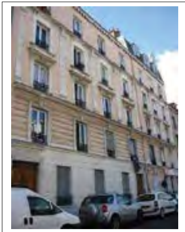
3, 3 bis et 5 rue Ernest Renan Département de la Seine-Saint-Denis, DCPSL, SPC
