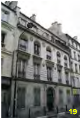
4 rue Aubert immeuble au décor soigné construit entre 1845 et 1854
