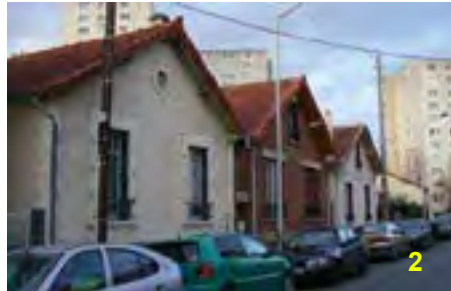
7 - 9 chemin Saint-Léger Mur pignon sur rue
