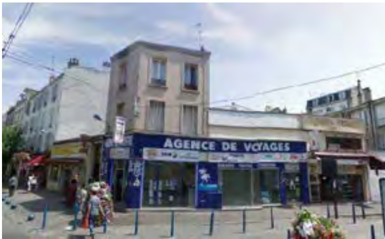
La parcelle du 27 rue Auguste Delaune forme un angle obtu au croisement comme son vis-à-vis le 3 rue Dezobry. Ce bâtiment a perdu tout son intérêt urbain et architectural (voir carte postale ancienne ci-dessous). Département de la Seine-Saint-Denis, DCPSL, SPC
