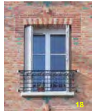
Volets escamotables métalliques se repliant dans l'embrasure extérieure
