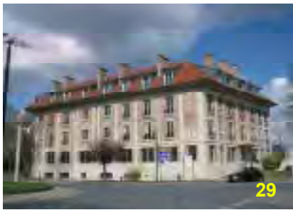
Bâtiment administratif à l'entrée des EMGP construit a posteriori sur le site vers 1930
