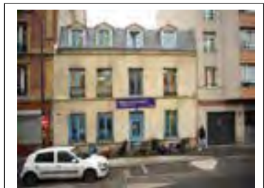
23 rue Dezobry © Jacques MANGIN - UASD - Département de la Seine-Saint-Denis
