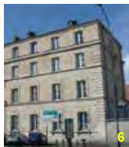
Appareil régulier et allongé marqué aux angles par une chaîne d'angle harpée à double hauteur d'assise
