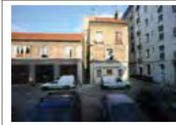
Vue du bâtiment de logement D (à droite) depuis la cour. © Jacques MANGIN – UASD - Département de la Seine-Saint-Denis.
