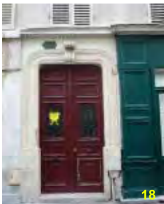
Rue Aubert La devanture ancienne a été restaurée permettant la préservation des éléments de modénature d'origine.
