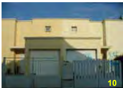
10 Lotissement Lurçat, rue Crox Les ravalements effectués, de teintes différentes, et les portails remplacés nuisent à la logique d'ensemble.
