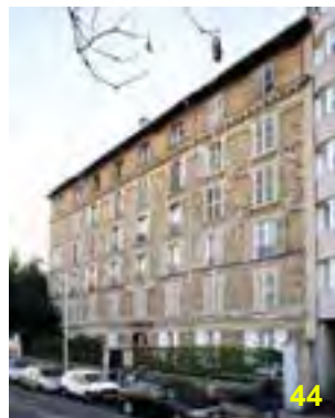
1902-1903 – logement social « l'Union » – G. Guyon (architecte) 8 rue Gaston Dourdin
