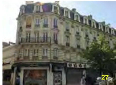
Au 93 rue de la République, pan coupé à trois travées.
