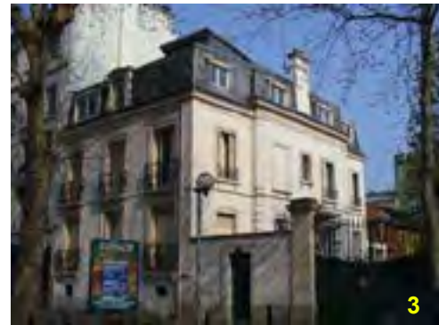
Maison de maître au 4 rue Paul Eluard
