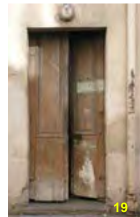
18 et 19 – Dans une même cour, la variété des portes nuit à la cohérence générale de la cour. La porte ancienne peut servir de modèle type pour remplacer l'ensemble des portes. Dans ce cas, il convient d'en faire un relevé précis avec profil des moulurations et de l'adapter à chaque ouverture en conservant les lignes directrices à la même hauteur (plinthe, cadres, etc...)
