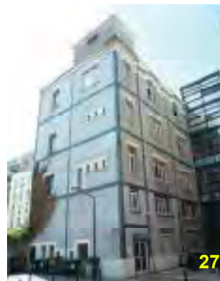
Edicule abritant la machinerie du monte-charge, ancienne usine Jeumont-Schneider
