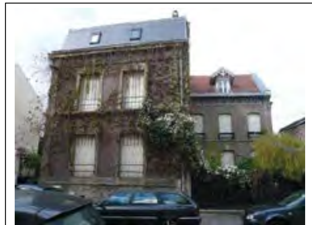
8 rue Denfert Rochereau (à gauche) et 6 rue Denfert Rochereau (à droite et en second plan) Département de la Seine-Saint-Denis, DCPSL, SPC
