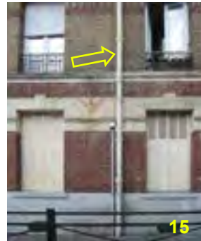
Descente d'eaux pluviales en fonte cannelée
