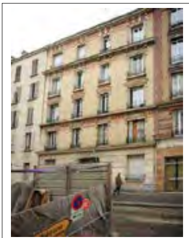
15 rue Dezobry © Jacques MANGIN – UASD – Département de la Seine-Saint-Denis
