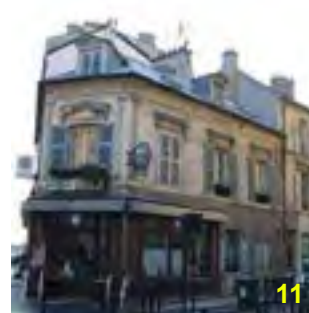
Couverture en zinc ayant très certainement remplacé le matériau d'origine
