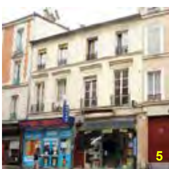
Au 16 rue de la Charonnerie, la façade au rythme régulier et niveaux décroissants a gardé ses éléments de modénature et notamment les dais surmontant les baies du 1 er étage.
