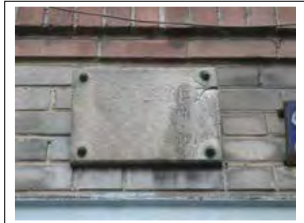
Le détail de la plaque d'architecte, quasiment illisible, située à gauche de la porte d'entrée au 246 rue du Landy. Un élément à préserver. Département de la Seine-Saint-Denis, DCPSL, SPC
