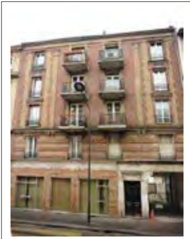
17 rue Dezobry © Jacques MANGIN – UASD – Département de la Seine-Saint-Denis
