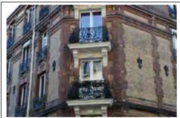
ci-dessus et ci-contre : le traitement de l'immeuble du n°8 allie architecture modeste en brique à un vocabulaire décoratif riche. © Jacques MANGIN – UASD – Département de la Seine-Saint-Denis
