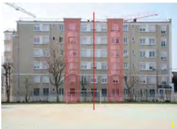
Composition symétrique avec un équilibre parfait entre les lignes verticales marquées, entre autres, par les oriel et horizontales mise en exergue par des jeux d'enduit formant des bandeaux horizontaux en encadrement des baies de forme carrée
