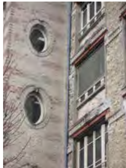
Mécano, soin de mise en oeuvre du bâtiment administratif
