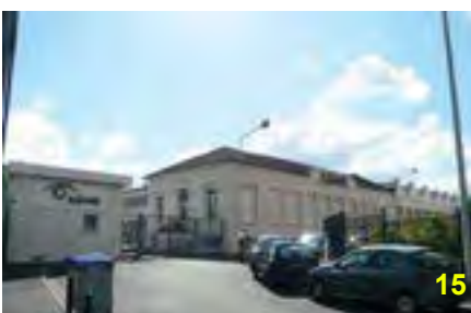
Hotchkiss, usine de fabrication d'armes puis de pièces automobiles, rue de Tunis
