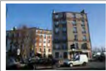
Façades des immeubles visibles depuis l'espace public. © Jacques MANGIN – UASD – Département de la Seine-Saint-Denis
