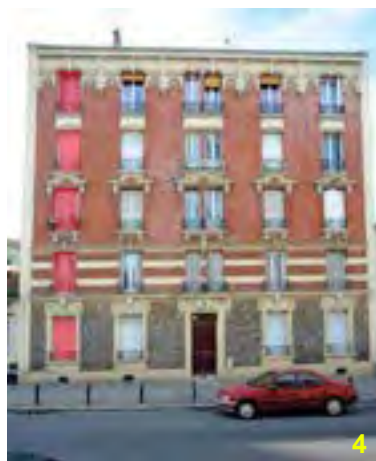
Façade symétrique et baies de dimension égale avec baies jumelées sur la travée centrale
