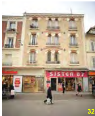
3 travées symétriques avec baies jumelées centrales au 87 rue de la République
