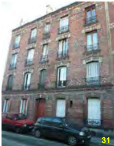
5 travées symétriques au 24 rue Jules Gényvési construit en 1907
