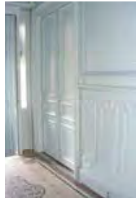
Certains décors ne permettent pas d'envisager une isolation par l'intérieur.
