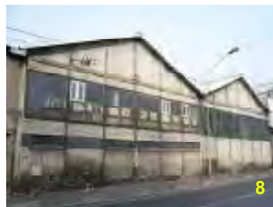
Usine de lessive Phenix Eclairage latéral par de grandes baies filantes au niveau des murs gouttereaux ou des murs pignon.
