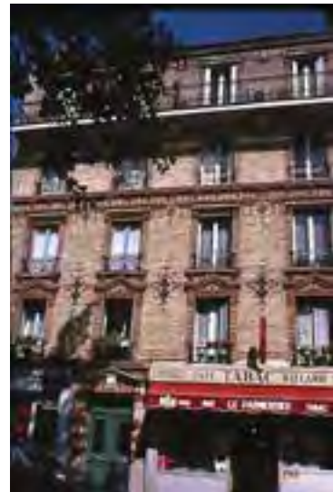
Détails du décor de céramiques architecturales au 4 rue Lorget. © Marc Silberstein – Direction de l'Urbanisme Ville de Saint-Denis - 1995
