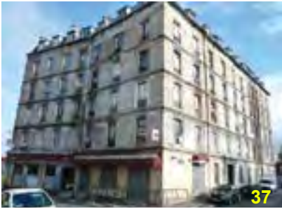
Logement patronal de l'entreprise Coignet en béton Coignet
