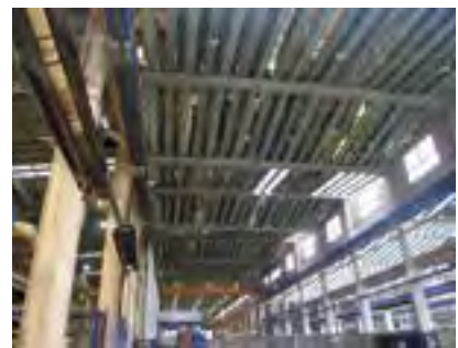
Halle en béton armé d'Alstom
