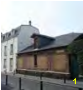
Rue Catulienne Bâtiment de service
