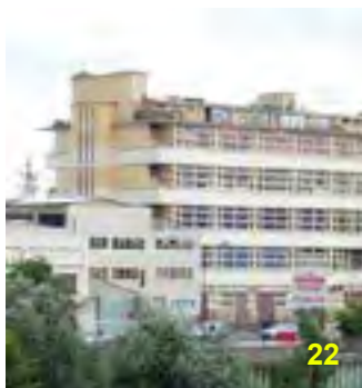
L'écriture horizontale prédominant sur la façade de l'usine Franicolor datant de 1949 est reprise au niveau des baies par un jeu de résille
