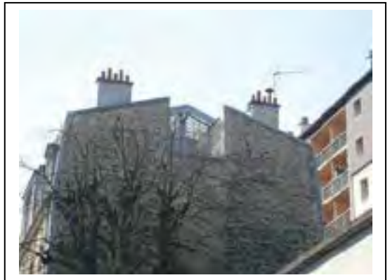
Détail du mur pignon Nord visible depuis l'espace public. Département de la Seine-Saint-Denis, DCPSL, SPC
