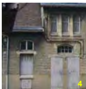
En soubassement l'assise des pierres est 3 fois plus haute qu'en élévation où le parement a une finition de type grain d'orge
