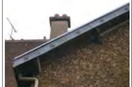
Détails de rive en zinc avec insertion de motif floral préfabriqué
