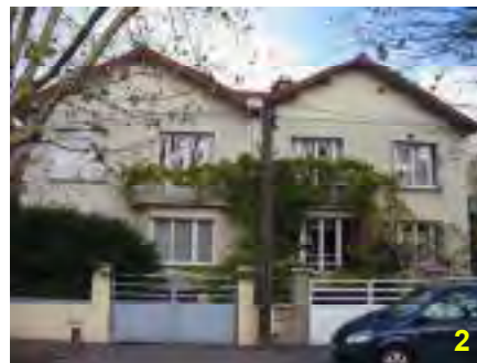
9 villa Anatole France En retrait, avec accès frontal, ces maisons en brique, presque symétrique (baies de largeur différente au 1er) sont intégrées dans le front bâti de la rue.
