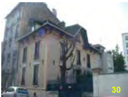
7 rue des Moulins Gémeaux
