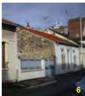
Couverture à deux pentes à 30° en tuiles mécaniques rue d'Arnouville
