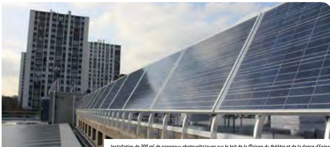
Installation de 200 m 2 de panneaux photovoltaïques sur le toit de la Maison du théâtre et de la danse d'Épinay
