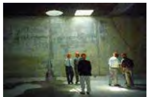
Bassin enterré visitable
