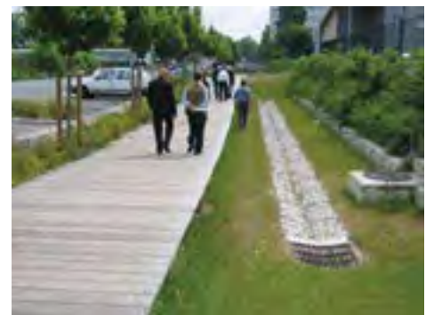
Noue de stockage à Clichy-sous-Bois
