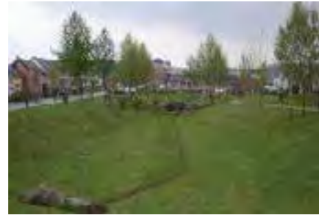
Bassin d'infiltration enherbé
