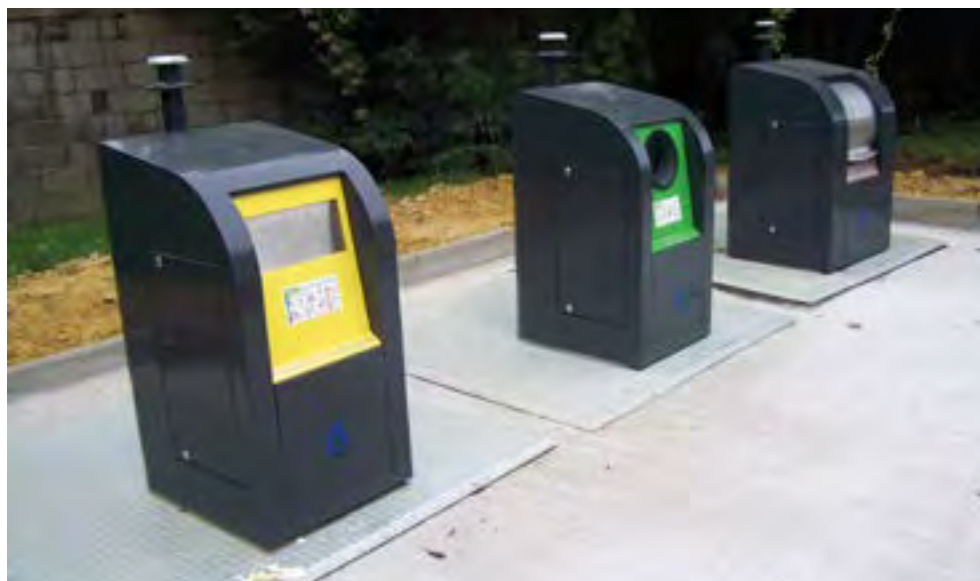
Colonnes enterrées pour les emballages, le verre, les ordures ménagères
